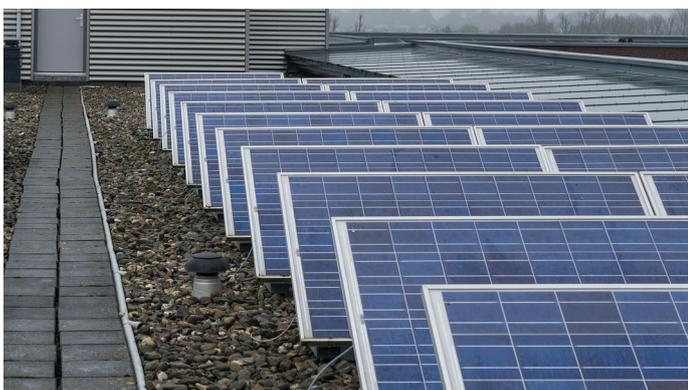
Unsere KIOTO Photovoltaik-Anlage hat eine Gesamtleistung von 5 Kilowatt-Peak (kWp) und produzierte im vergangenen Jahr über 4.800 Kilowattstunden nachhaltigen Strom aus Sonnenenergie. Dadurch konnten wir in den letzten 12 Monaten fast 80 Prozent des Energiebedarfs des Pfarrhofes mit „grünem Strom“ aus eigener Produktion abdecken. Damit hätten wir auch ein Elektro-Auto über eine Strecke von rund 11.000 Kilometern betreiben können.
